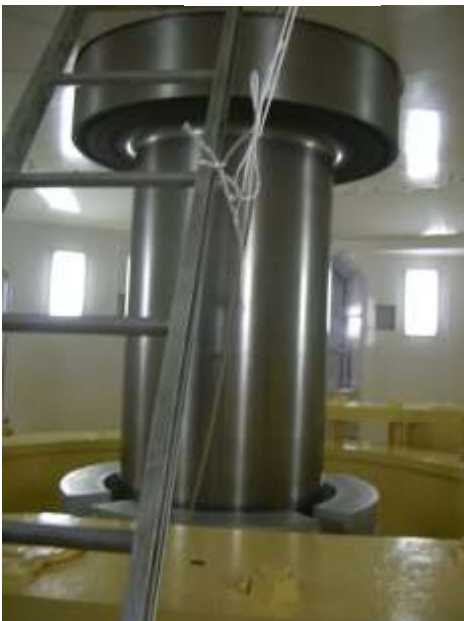
フランスス水車、発電機軸受 (振動、回転数を計測)
