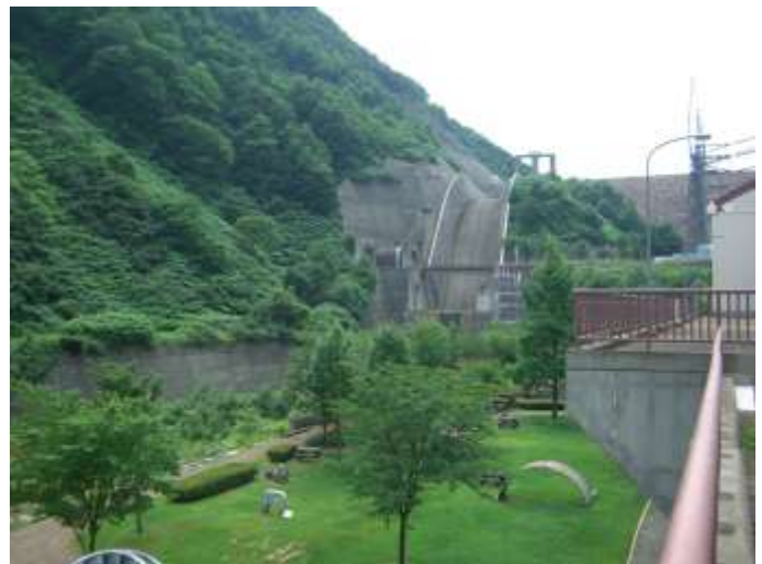
下部貯水池と洪水水門
